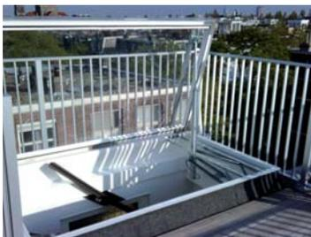
Dachausstieg, mit elektrischer Bedienung
