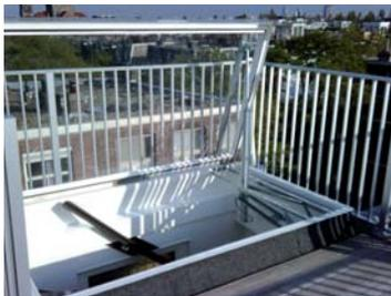
Dachausstieg, mit elektrischer Bedienung
