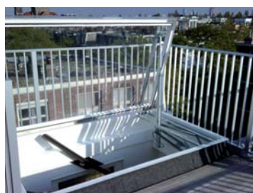
Dakbetreding, met elektrische bediening
