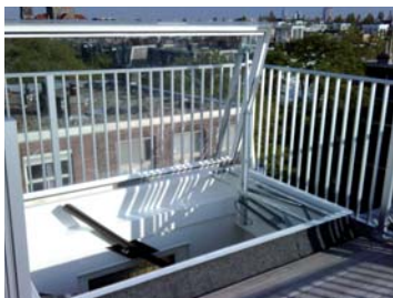
Accès toiture à commande électrique
