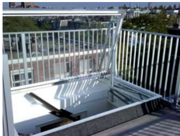
Dachausstieg, mit elektrischer Bedienung
