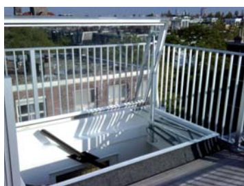
Dakbetreding, met elektrische bediening
